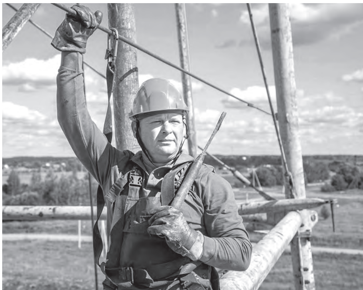
Вышкомонтажник Александр Лопатин более 20 лет строит буровые установки.
